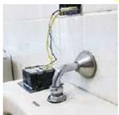
既設洗浄管の長さが短い現場やセンサーの露出ができない現場に対応できます。
