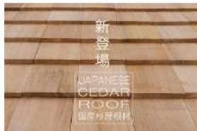
木の断熱性能は、冬の寒さ、夏の暑さを建物内部に伝えにくい性能があります。屋根そのものが断熱層となり、省エネルギーの効果が発揮されます。木の断熱性能は「鉄の413倍」「アルミの200倍」「コンクリートの8倍」といわれています。
